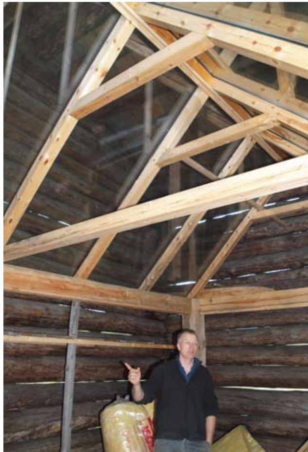
“Glashus” til overnatting under bygging i gamal høylåve på gardshotellet Gammel-Kleppe, Vågå, Oppland.
